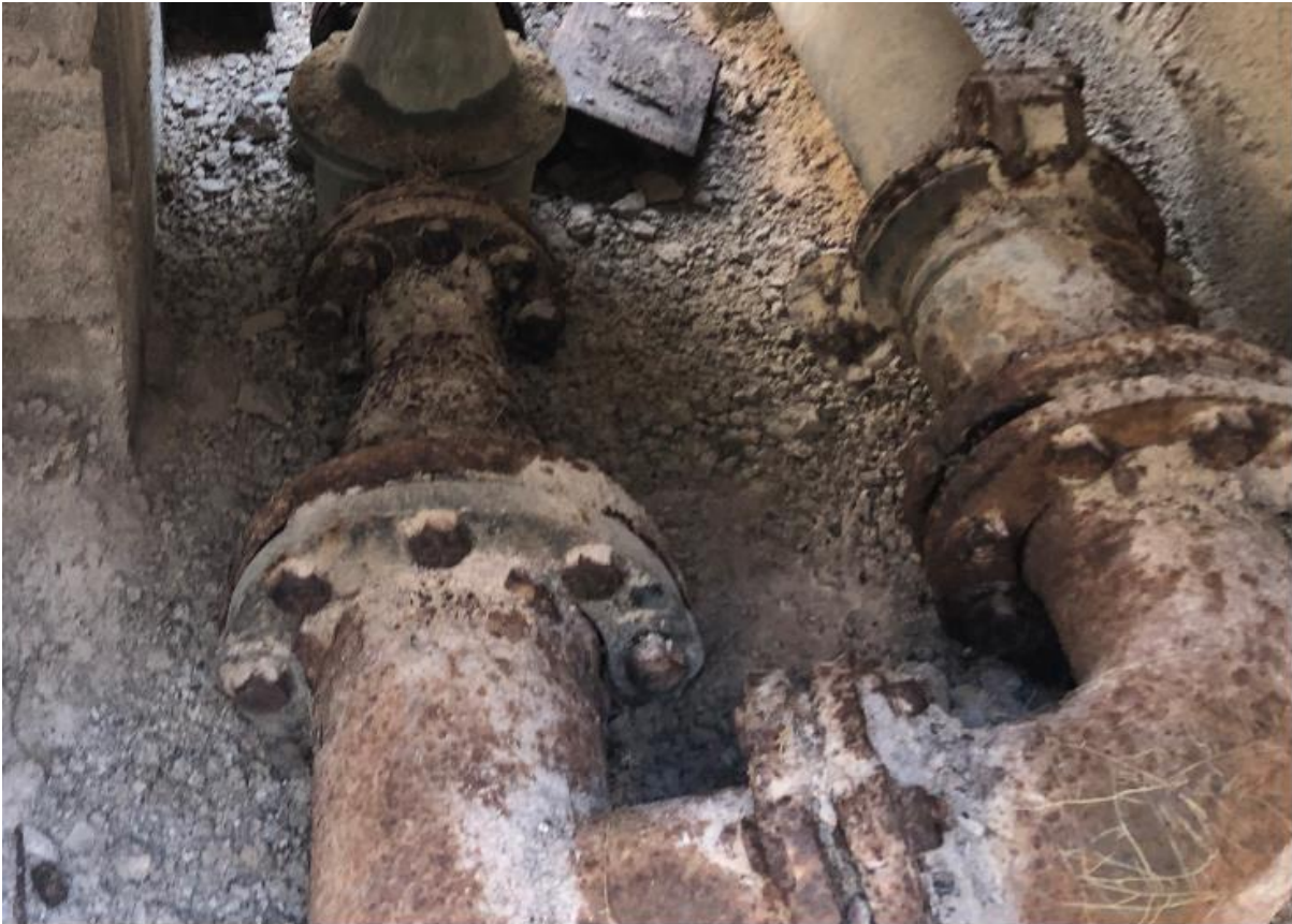
Canalisation principale au niveau de la villa COMAR. Notez l'état de corrosion avancé !
